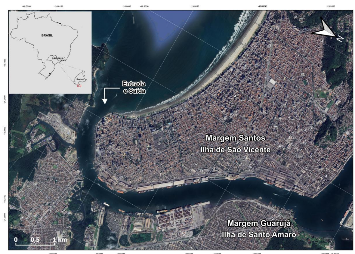
Figura 2. Complexo portuário localizado ao longo do estuário do Porto de Santos (SP) com instalações na margem direita na Ilha de São Vicente (Santos) e na margem esquerda na Ilha de Santo Amaro (Guarujá).
