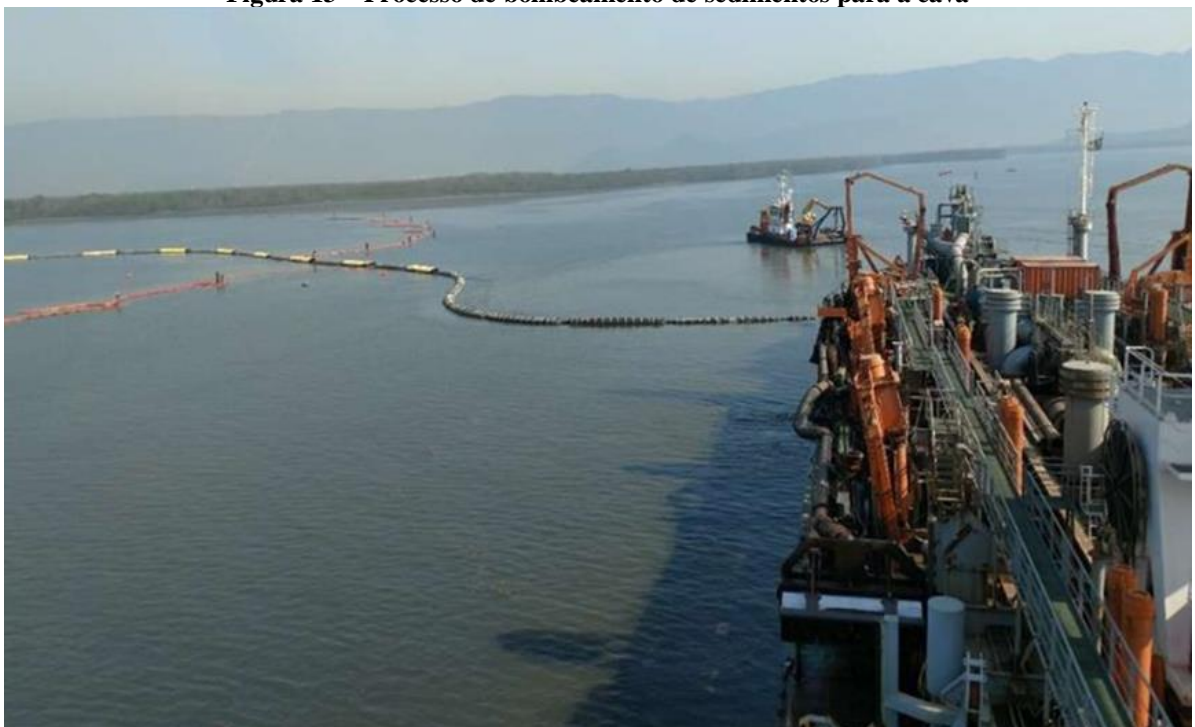
Figura 13 – Processo de bombeamento de sedimentos para a cava
