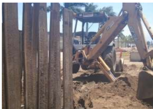
Fotos 03 e 04 – A primeira foto retrata a medição do ruído onde foi realizada a vistoria, enquanto a segunda foto retrata a retroescavadeira retirando a terra para fazer o escoramento.
