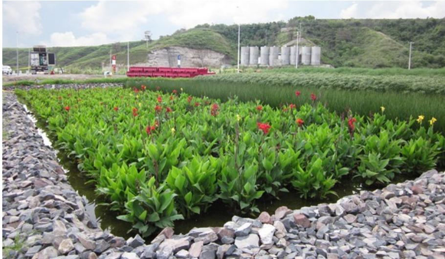
**Figura 5: Tratamento por áreas úmidas construídas (BIOHABITATS, 2017).**
