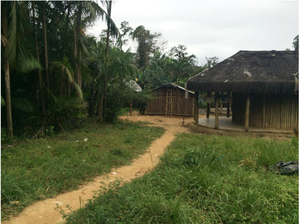
Figura 07: Moradias da terra indígena Ribeirão Silveira, construídas com pau a pique, sapé e palha de guaritana.
