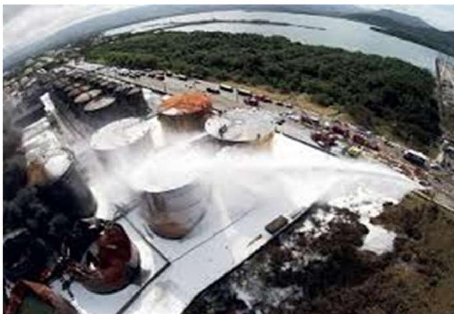
**Figura 1- Combate ao Incêndio ocorrido no Terminal Petroquímico da Ultracargo em Santos/SP, com a liberação de grande volume de LGE – AFFF.**
