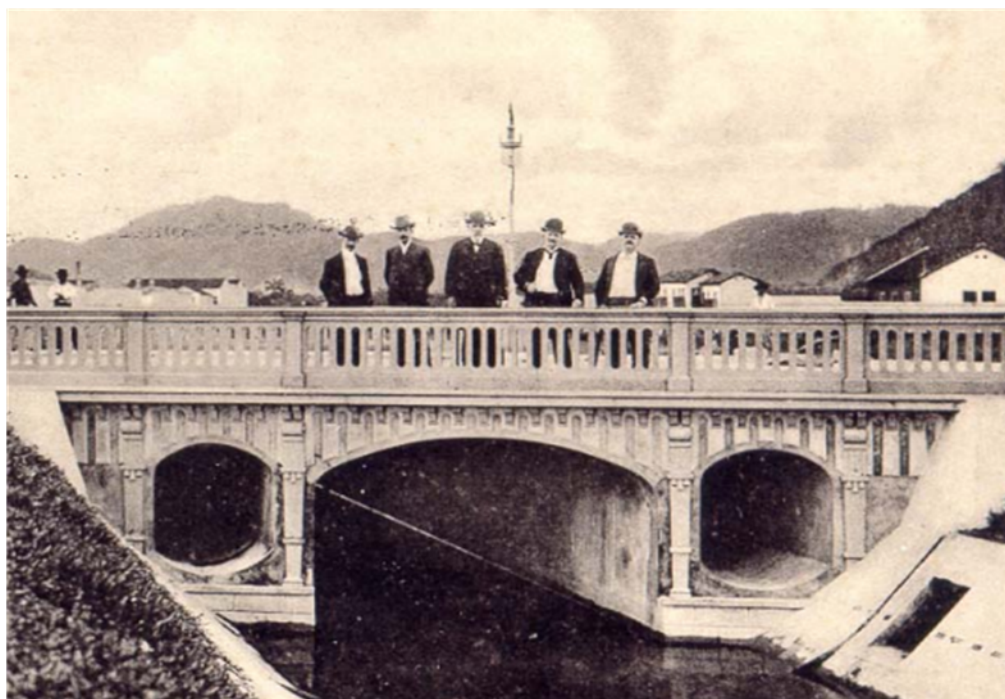
Figura 3 – Canal em obras
