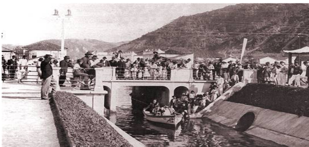
Figura 2 – Inauguração de canal Fonte: Brito (1943)
