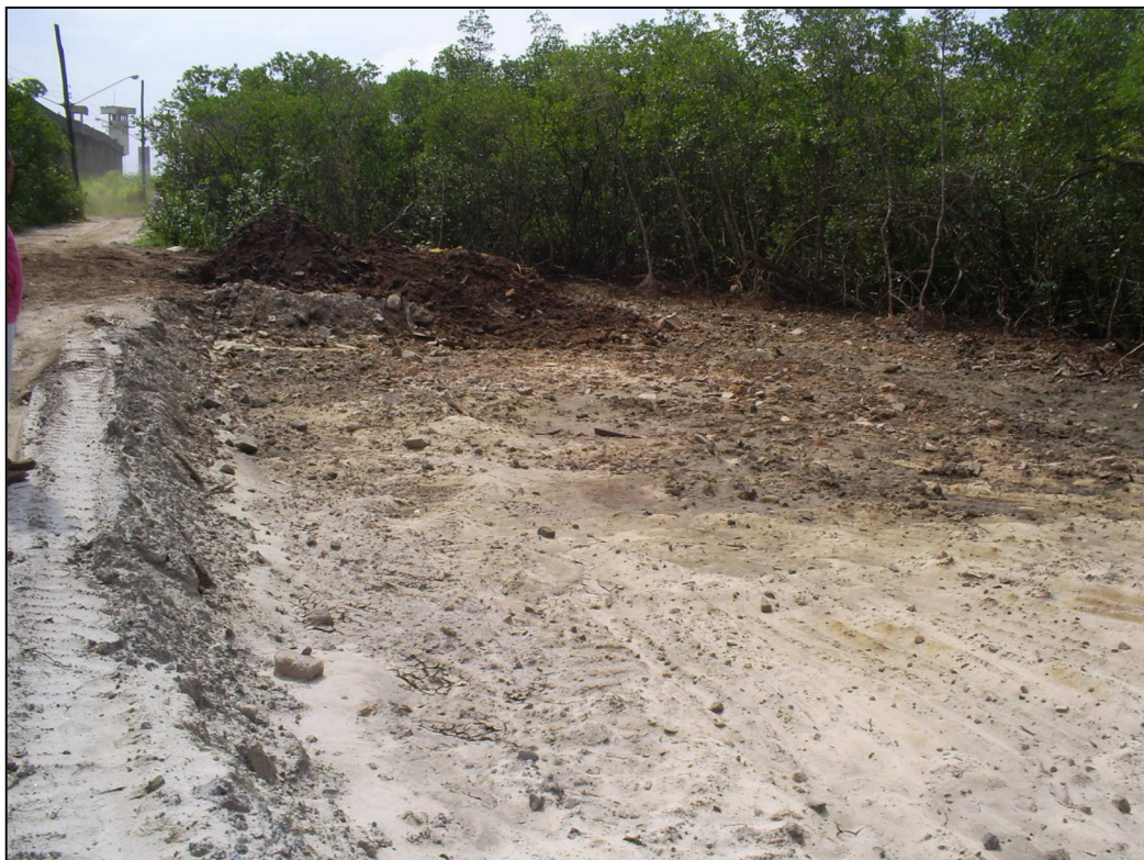
Foto 2 - Retirada do aterro. Fevereiro/2010. Fonte: Sabesp.
