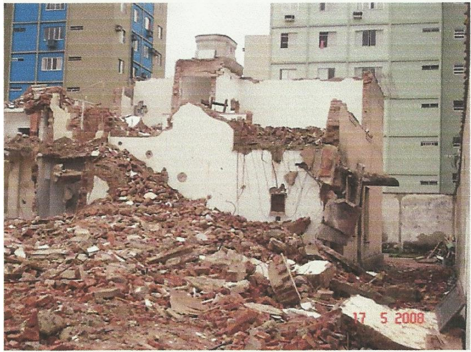
Figura 3 - Entulho de obra em demolição
