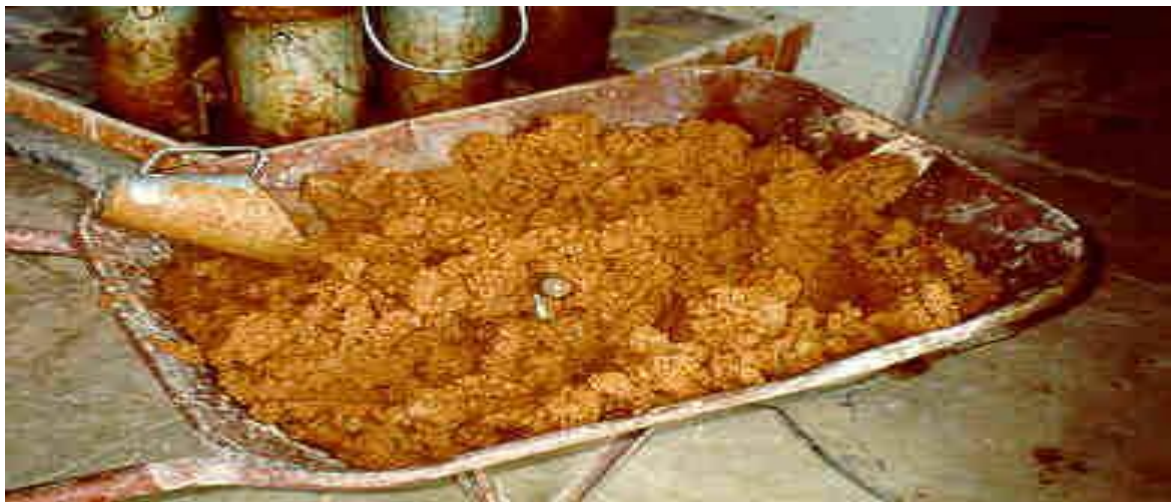
Figura 12 - Mistura do agregado miúdo com cimento e água (argamassa).
