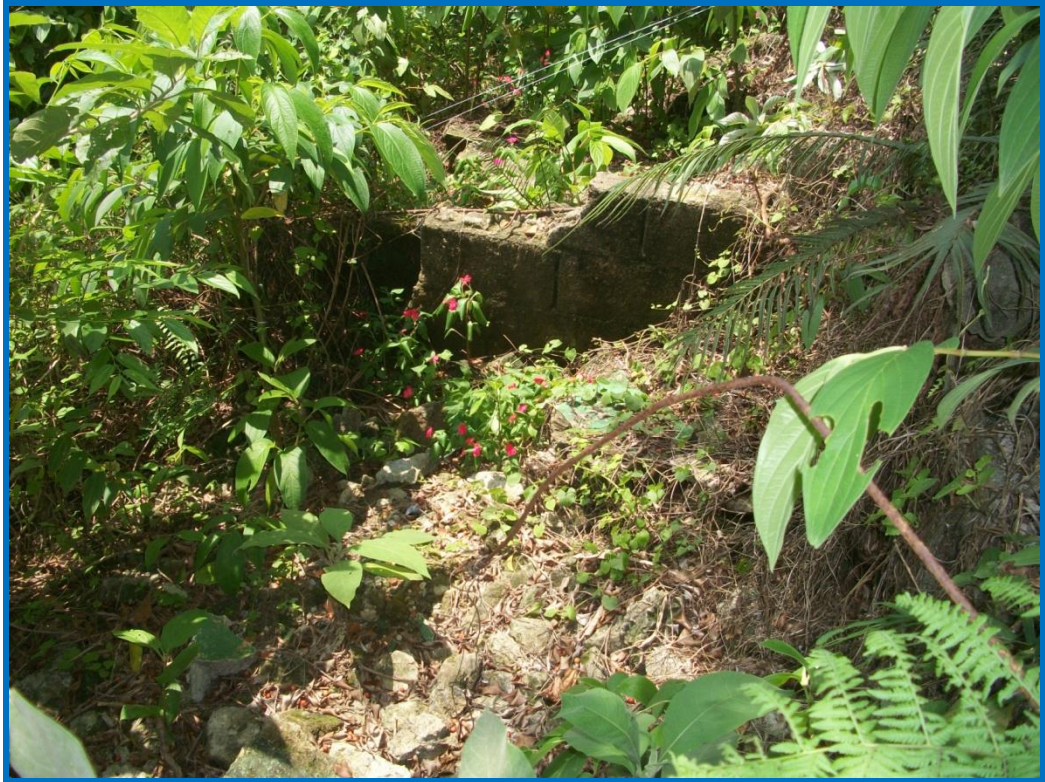
Foto 5: Detalhe da inclinação superior a 45° - Área III.
