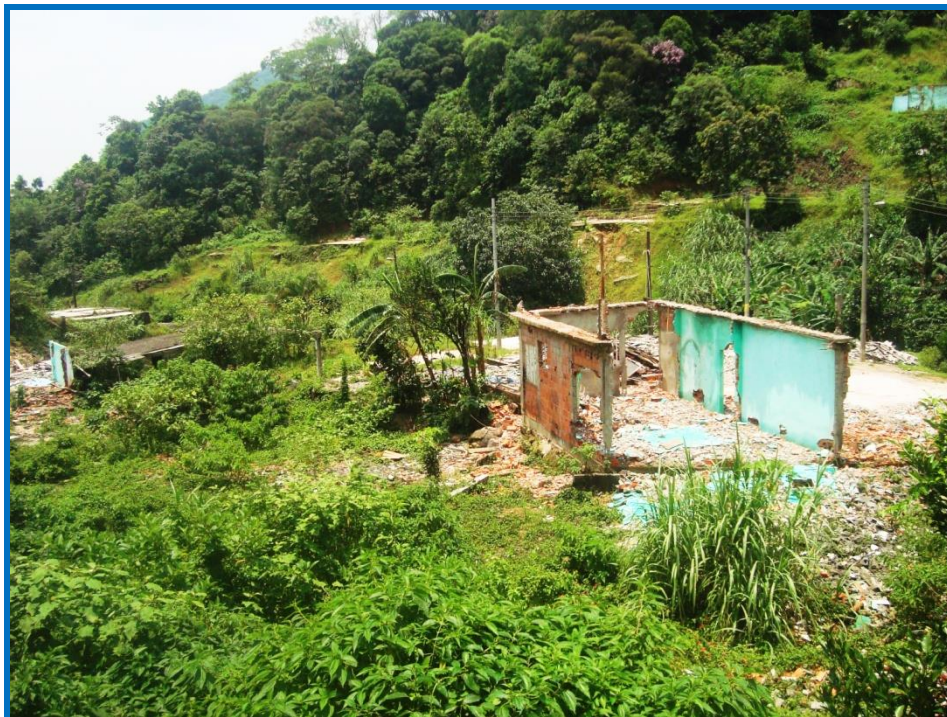
Foto 1: Demolição das construções irregulares no Grotão (Área III).
