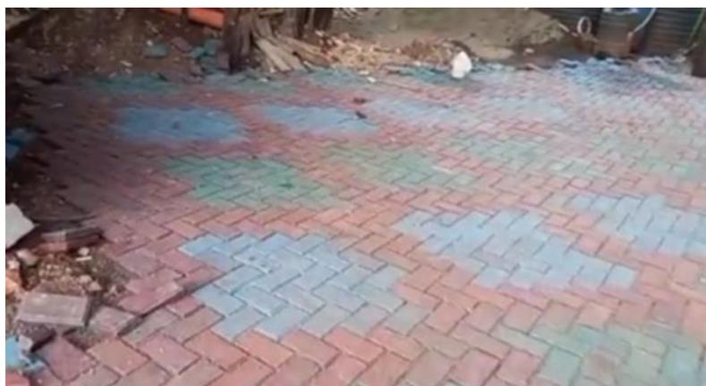
Figura 6: Figura de piso feito de blocos de plástico na composição.
