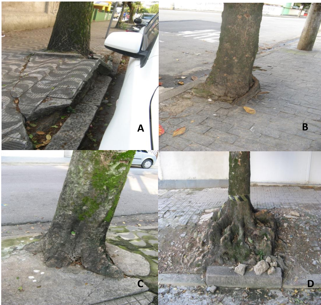
Figura 17. Espaços inadequados para as árvores e seus problemas: A. Calçamento levantado por raízes. B. Ausência de área livre de pavimentação. C. Raízes concretadas. D. Calçada destruída por raízes danosas.
