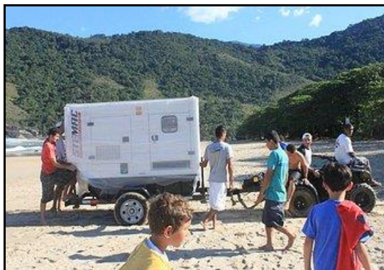
Figura 18 - Chegada na comunidade do Gerador doado pelo Instituto Bonete. Fonte: Site IB (2013).
