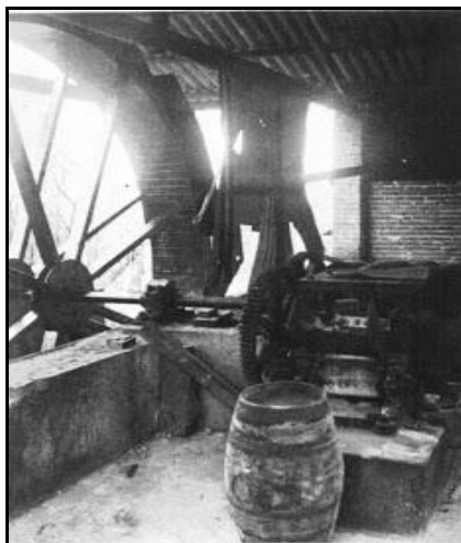
Figura 2 - Roda D'água de Engenho de cana de açúcar (séc.XIX). Fonte: Portal Ilhabela.
