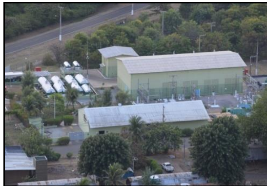
Figura 25 - Vista aérea da Usina Termoelétrica Tubarão – CELPE. (Abr. 2015).
