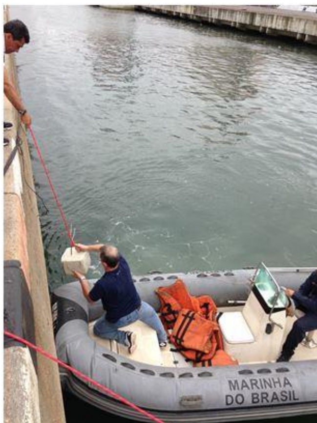
Figura 25 – Operação de embarque da poita.
