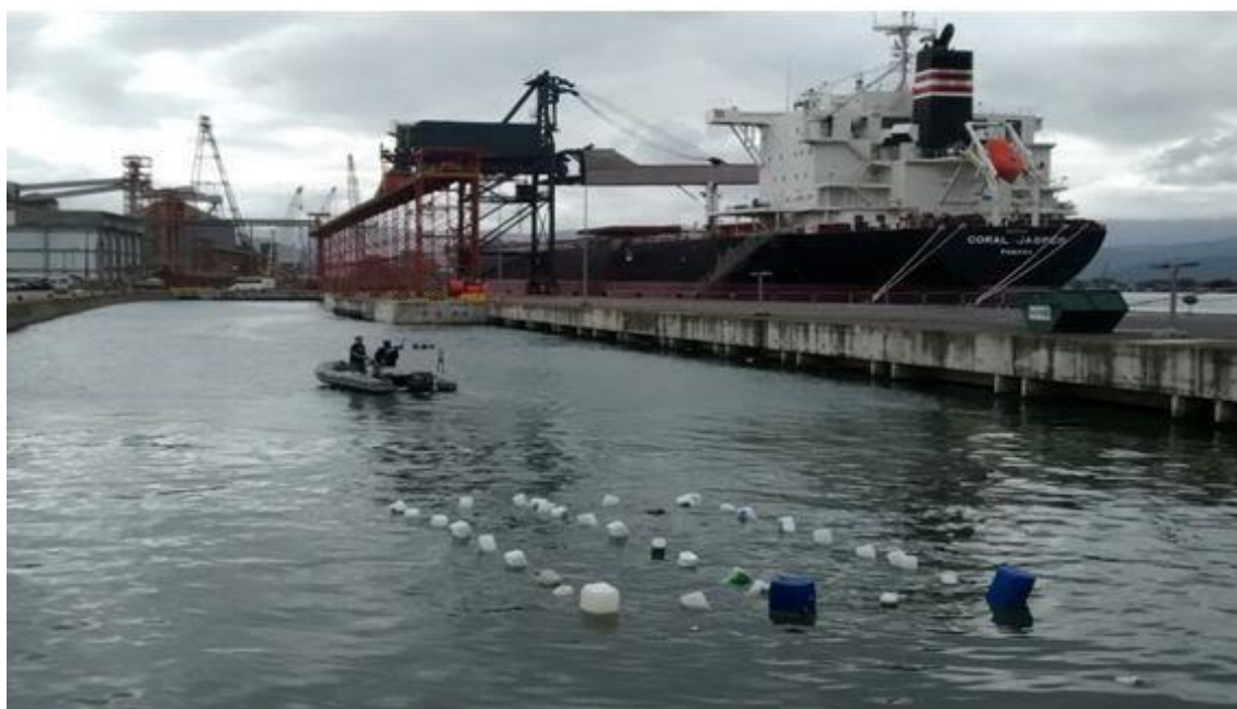
Figura 26 – Sistema de flutuação já instalado.
