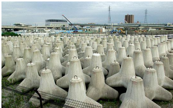
Figura 4 - Pátio com tetrápodes. Fonte: Hassouni 2014.
