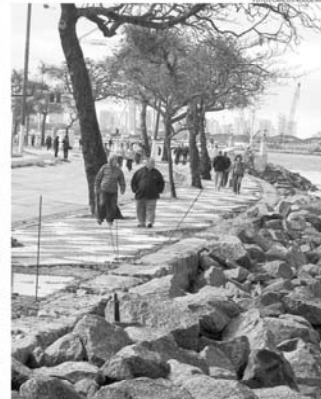
Como de costume, as muretas também foram levadas pelas águas
