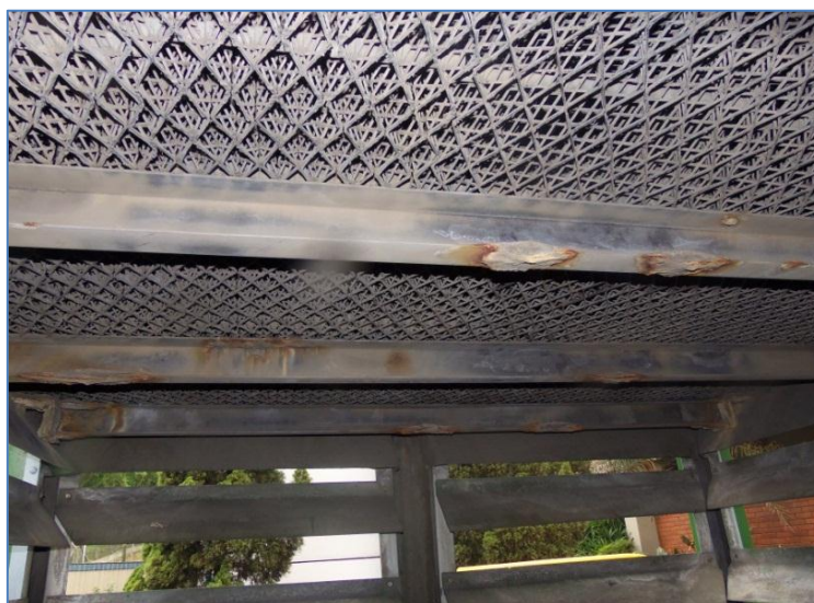
Figura 9 - Enchimento tipo respingo. Fonte: Grupo Hidromar, 2016.
