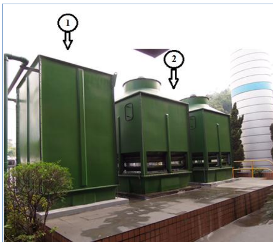
Figura 15 - Local de realização das medições experimentais nas duas torres (1) Torre de tiragem mecânica forçada; (2) Torre de tiragem mecânica induzida.
