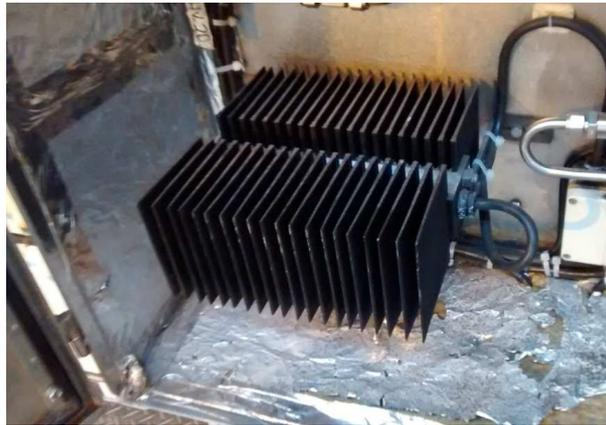
**Figura 22 – Detalhe de um aquecedor elétrico e do isolamento térmico em um gabinete de condicionamento de amostras.
