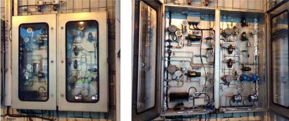
**Figura 21 - Gabinete típico de condicionamento de amostra.
