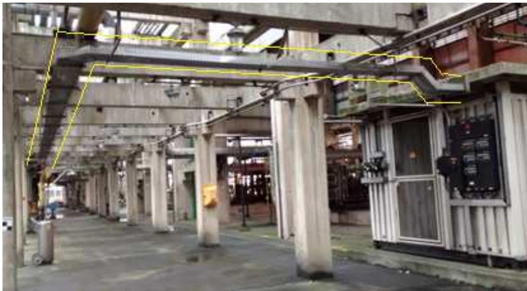
**Figura 16 – Vista de uma bandeja de suportes de tubo de transporte de amostra.
