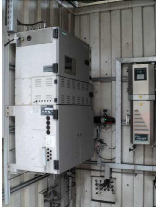
**Figura 18 – Cromatógrafo de processo para gás natural.
