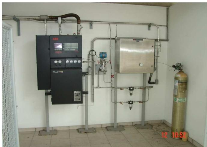
**Figura 02 – Cromatógrafo de processo.
