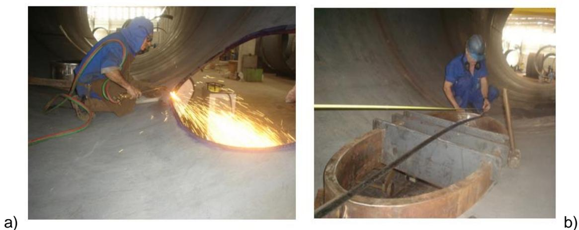
**Figura 12: Preparação de batente e porta de acesso a parte interna de um torre eólica a) corte oxiacetileno e b) alinhamento e nivelamento do batente.**
