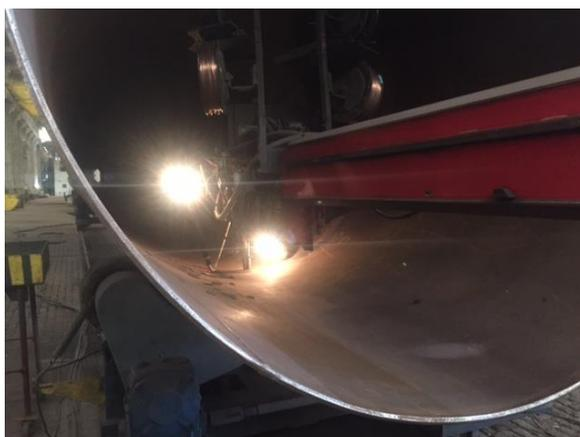
**Figura 8: Execução da Soldagem Circular Interna de uma seção tronco-cônica de uma torre eólica.**
