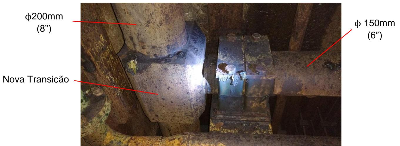
Figura 5 - Nova derivação instalada na linha de descamação.
