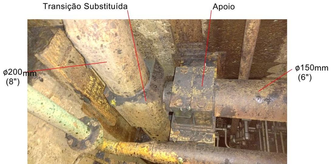
**Figura 32 - Detalhe do trecho de tubulação existente.**
