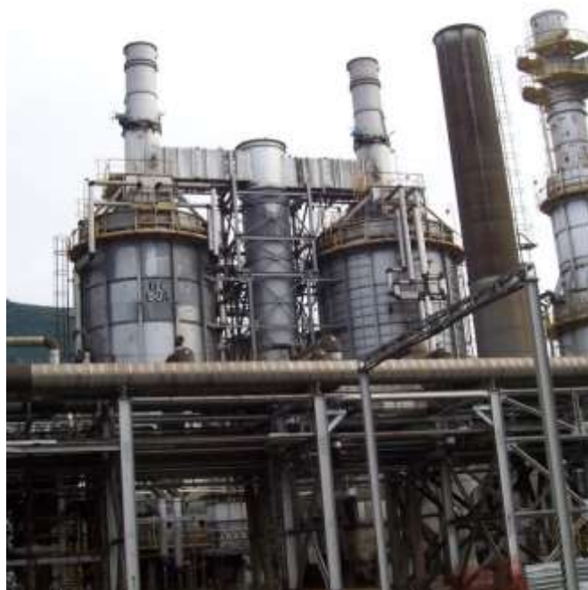
Figura 10. Forno de destilação atmosférica de petróleo.
