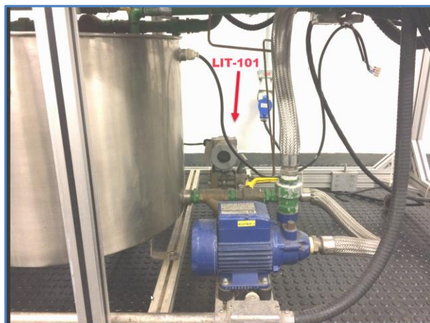
Figura 60 - . Instalação do LIT-101.
