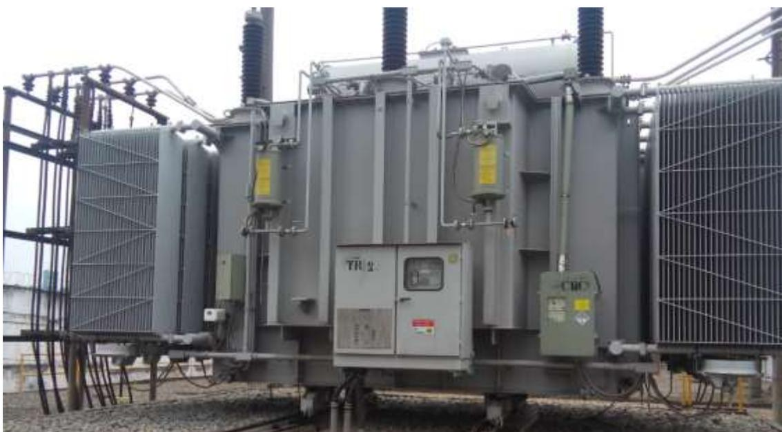
**Figura 1. Transformador de 40/60MVA isolado a óleo mineral de Guaianazes/São Paulo tipo ONAF com comutador de 17 posições.**
