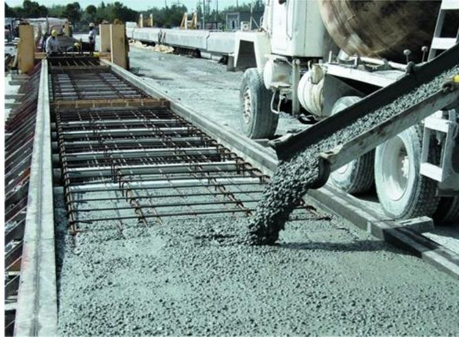
Figura 6: Concreto usinado e transportado em caminhão betoneira.
