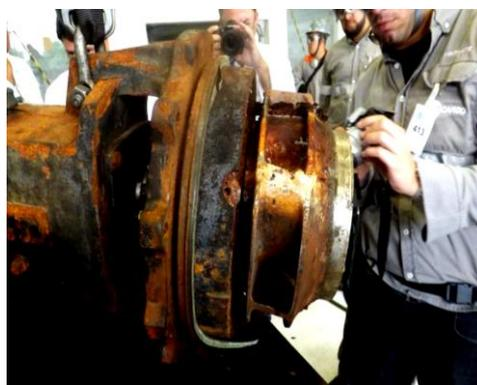
**Figura 30** – Desmontagem completa da bomba B-2644.
