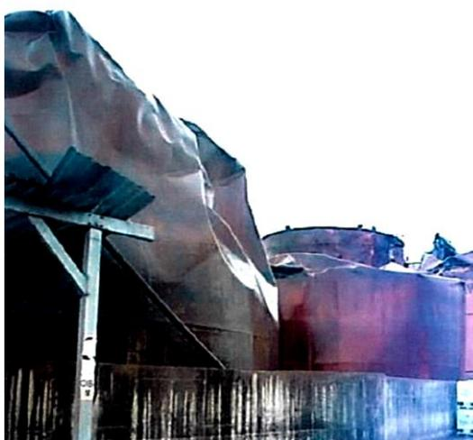
Figura 45 – Estado de tanques na CETRAN IV após o incêndio.
