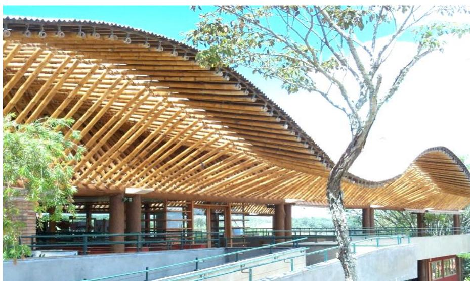
**Figura 8 - Centro cultural no Brasil construído com bambu.**
