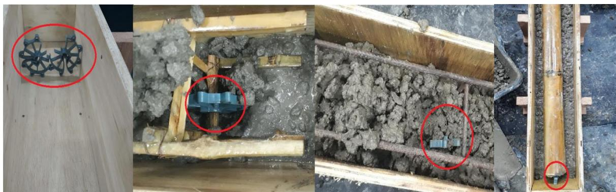
**Figura 65 - Espaçamento entre a armação e a forma.**
