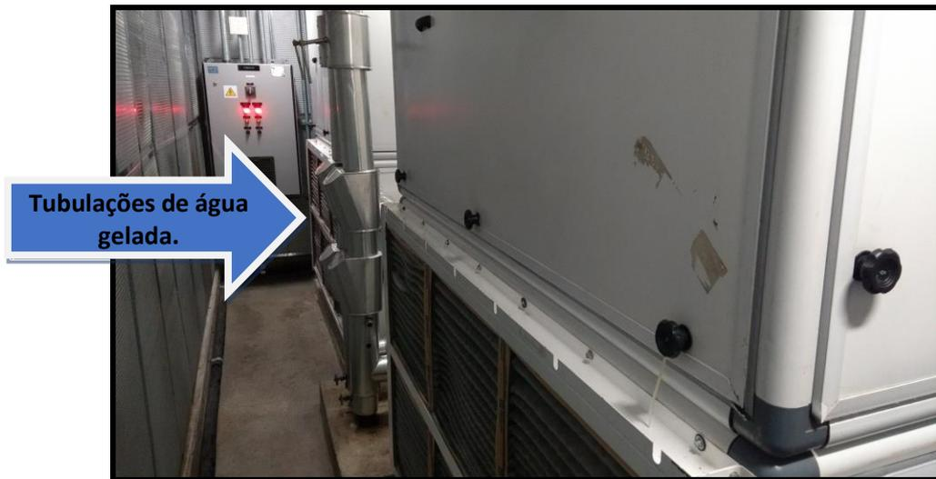
**Figura 13 – Condicionadores de ar tipo *fan coil*.**
