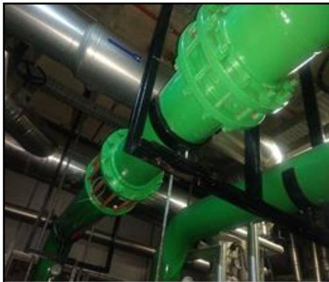
Figura 16 - Válvula reguladora de fluxo, *Flow Con*.
