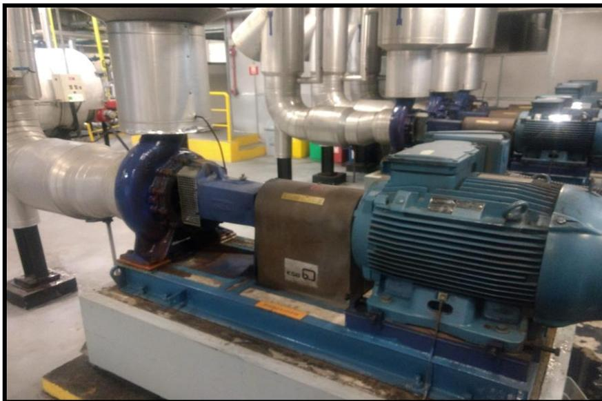
Figura 11 – Conjunto motor com bombas centrífugas.
