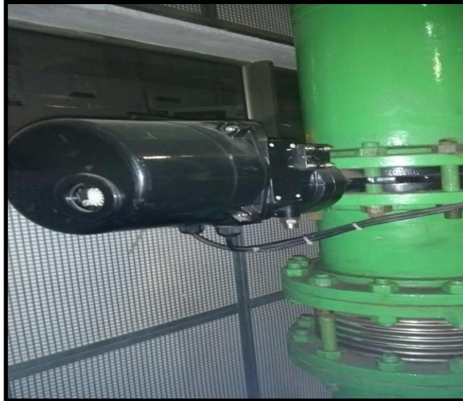
Figura 15 - Válvula borboleta motorizada.
