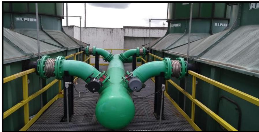
Figura 29 - Tubulação de entrada de água quente nas torres estudadas.
