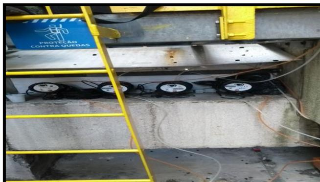
**Figura 34- Bombas dosadoras automáticas das torres.**
