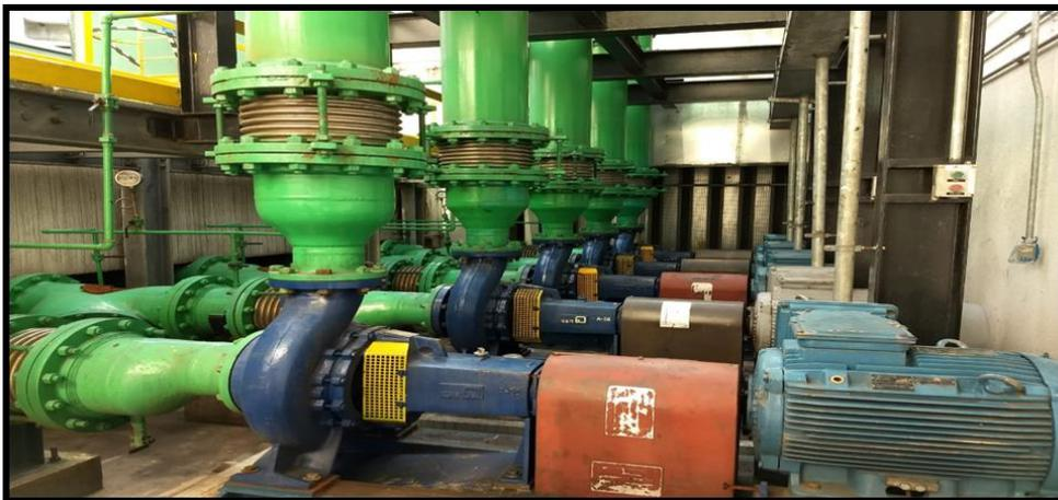
Figura 27 - Bombas centrífugas do circuito de condensação estudado.
