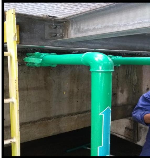
**Figura 24 - Válvulas de enchimento automático e manual rápido da torre estudada.**
