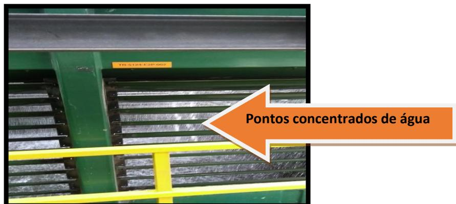
Figura 32 - Queda de água real com falha no distribuidor nas torres estudadas.
