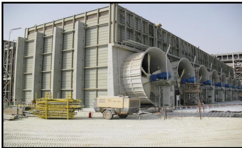
**Figura 8 - Torre mecânica de tiragem forçada.**
