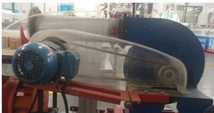
Figura 11 - Mecanismo de ventilação da Unidade Piloto visto de lado (AUTOR,2023)
