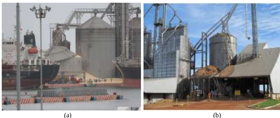
Figura 2: Colapso de silos. (a) no porto de vera cruz, (b) Brasil. Fontes: Google, 2019, CONPAT, 2015.
