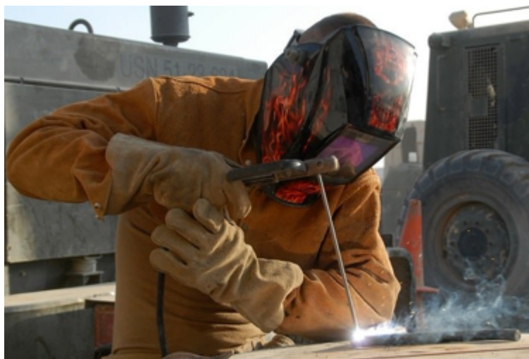
Figura 16: Soldagem por processo MMA. (Fonte: adaptado internet 2019)
