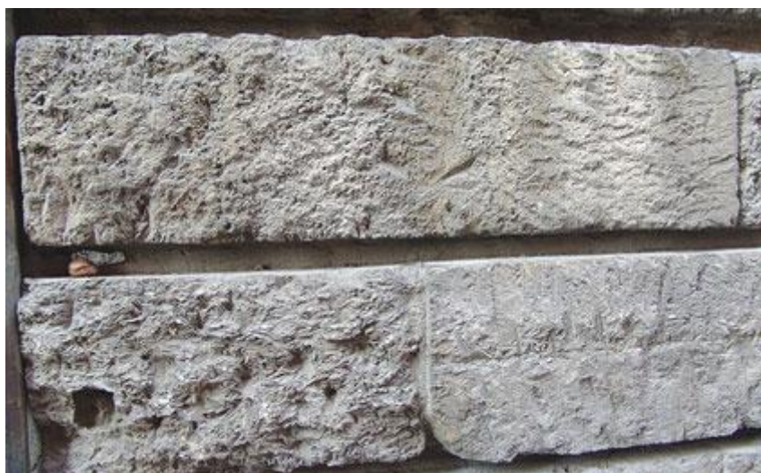
Figura 2 - Bloco para construção civil feito com fosfogesso. Fonte: http://www.ecodesenvolvimento.org/noticias/fosfogesso-solucao-sustentavel-para-a-construcao (Acesso em 27/10/2019)
