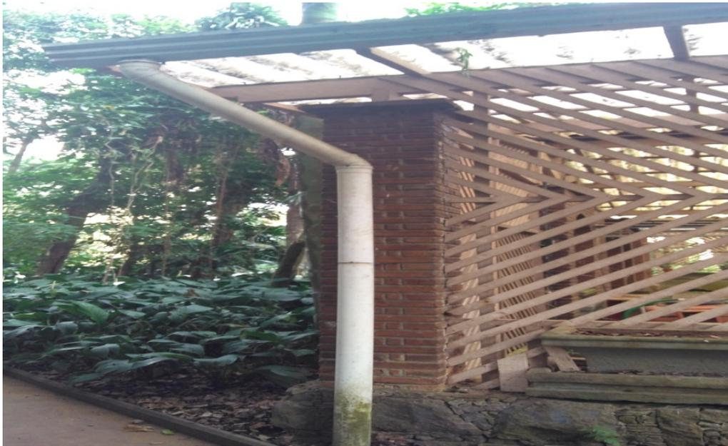
**Figura 15. Sistema de condução da água de chuva**
