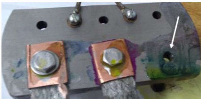
Figura 53 - Primeiro ponto de conexão.
