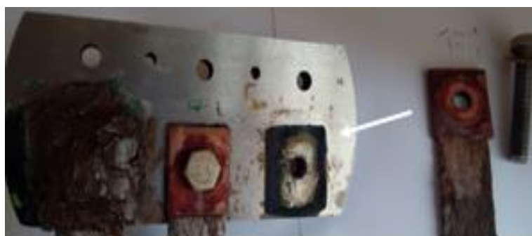
Figura 67 - Primeiro ponto de conexão com parafuso e arruela de latão.
