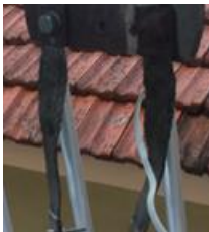
Figura 35 - Conjunto fixado em área externa.
