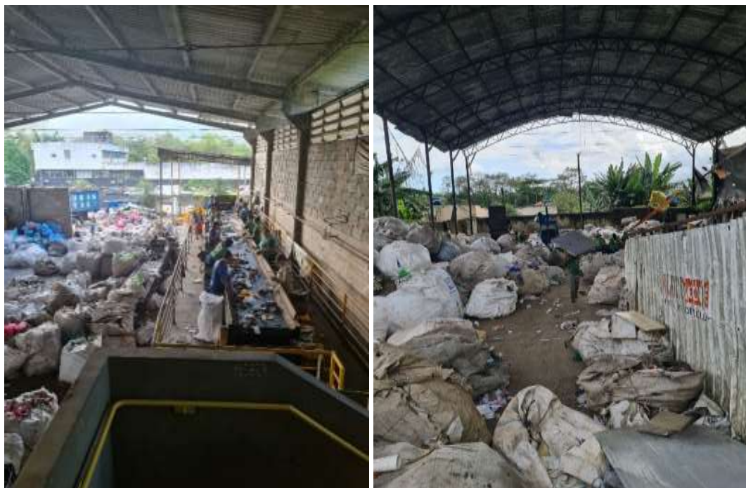
Figura 14 e 15 – Estrutura de cobertura do galpão, cooperativas CUB 1 e SV 1, respectivamente.
