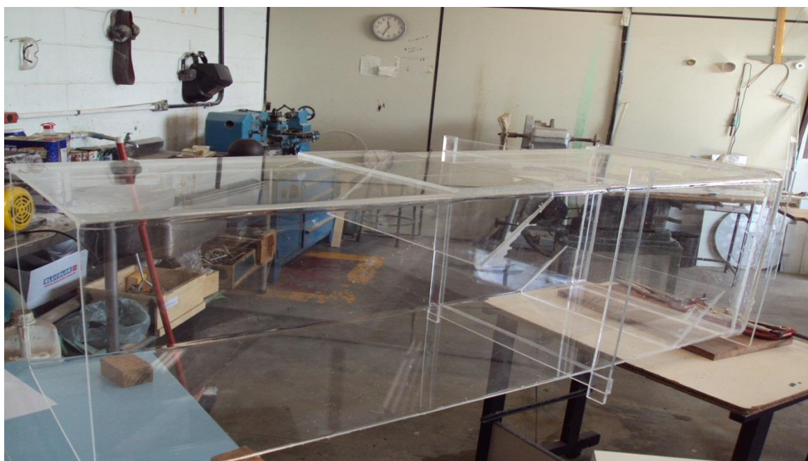
Figura 3.7 – Construção do tanque.
