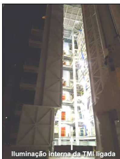
Figura 27 – Subsistema de iluminação interna.
