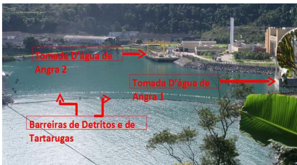
Figura 12. Esquema de projeto de Barreiras de detritos e de tartarugas, tomada d'agua de Angra I, tomada d'agua de Angra II.
