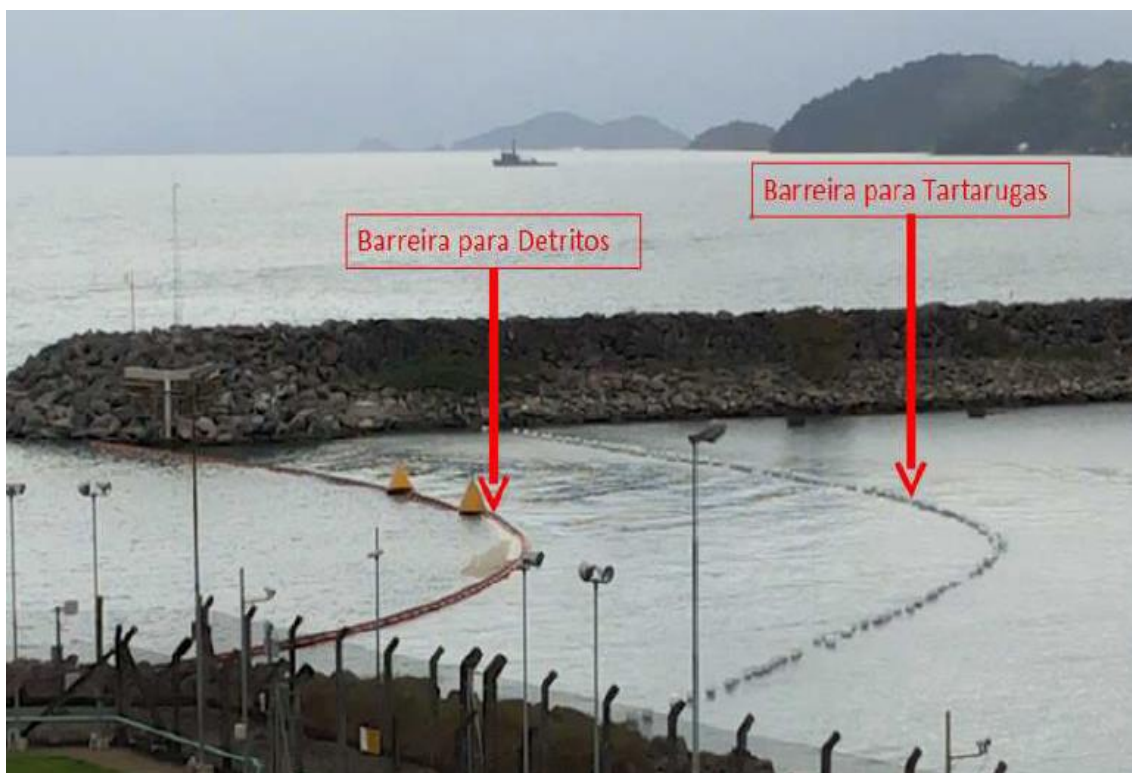
Figura 13. Barreira para Detritos, Barreira para Tartarugas, para proteção da usina de Angra. Fonte: nº 0031063-82.2016.4.02.5111.
