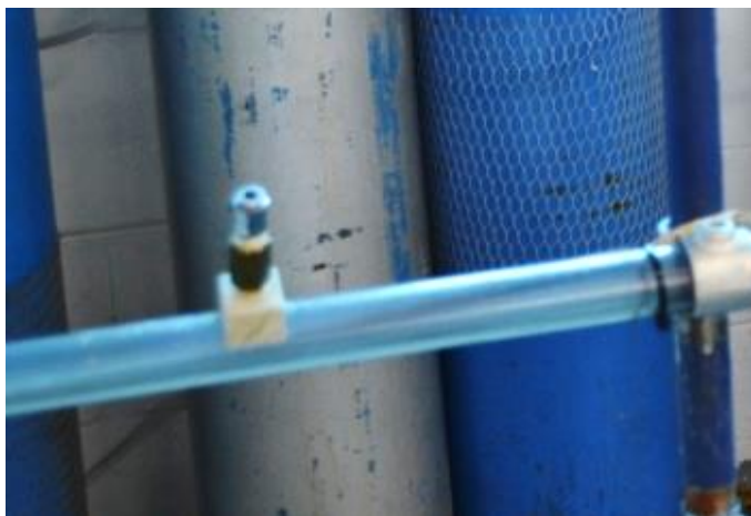
Figura 3-20 - Detalhe da figura 3-13 mostrando a tubulação após o processo de limpeza.
