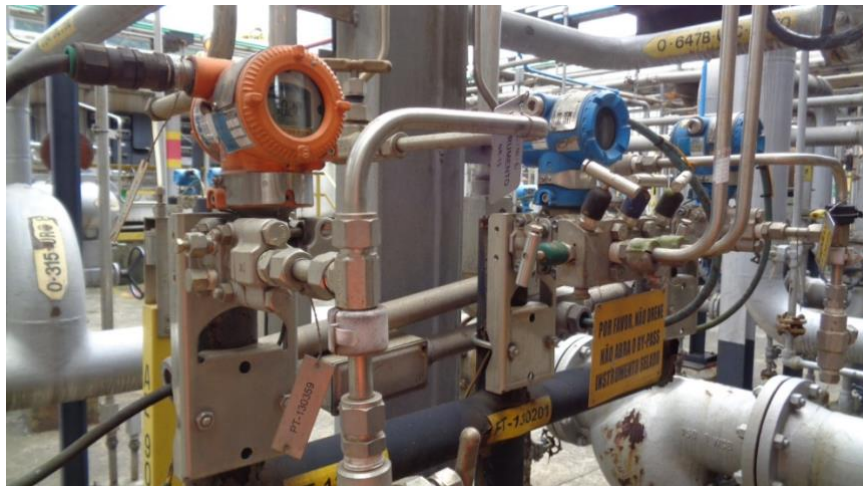
Figura 31. Instrumentos de monitoramento das variáveis de processo.
