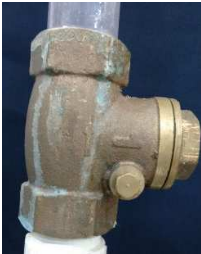
Figura 4.11 – Válvula de retenção.
