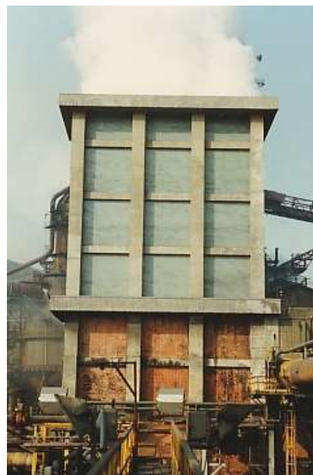
Figura 18 – Torre de Extinção
