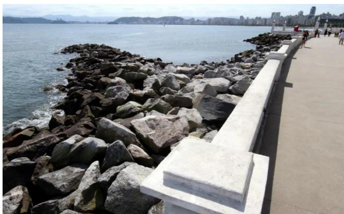
Figura 21: Barreiras para contenção de ondas e erosão costeira na praia de Santos.
