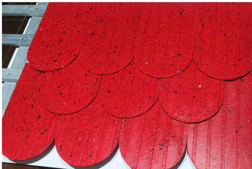
Figura 29. Foto do modo de instalação das telhas na estrutura, em forma de escamas de peixe.
