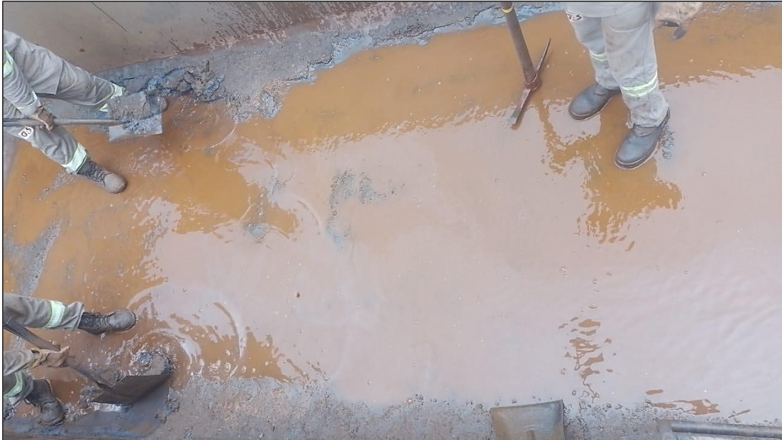
Figura 6 – Acúmulo de minério dentro do vagão visto de cima.
