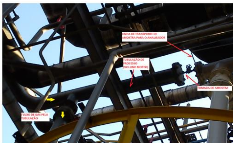
Figura 3. Detalhe da captação de amostra no processo.
